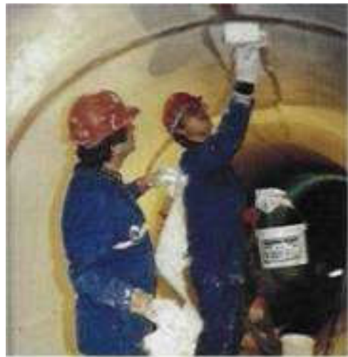
Rematado interior en visitable.
