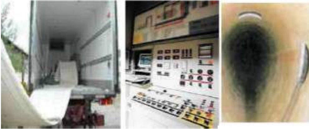
Control de la operación. Interior tubería rehabilitada.
