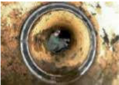
Vista reparación realizada
