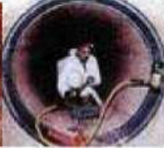
Colocación Manguito y Verificación estanqueidad
