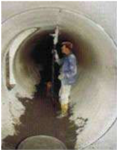
Inyección Manual en visitable.
